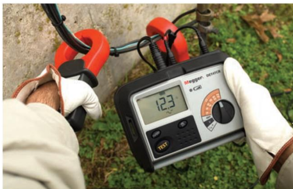
Pomiar rezystancji uziemienia miernikiem DET4TCR2 metodą dwucęgową bez użycia elektrod pomocniczych.
