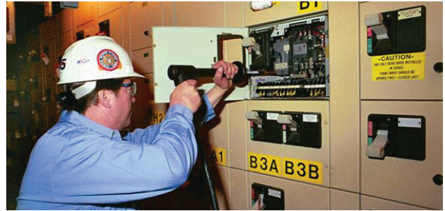
Prueba de MCCB con la sonda HCP2000
