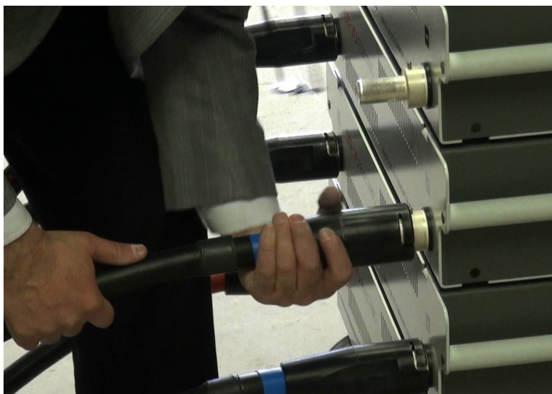
Abb. 29: Verkabelung der Stromkabel.
