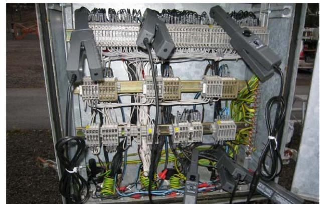
Figure 3 : Armoire de contrôle avec les pinces ampère métriques
